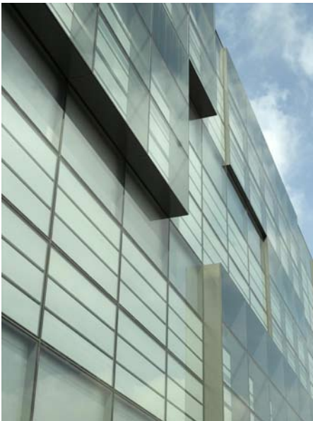
Exempel på fasadbeklädnad
